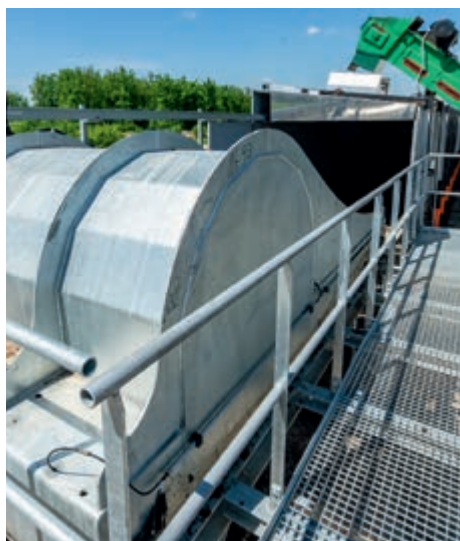
Устройство за разбъркване паркирано в началото на системата откъм страната за пълнене
