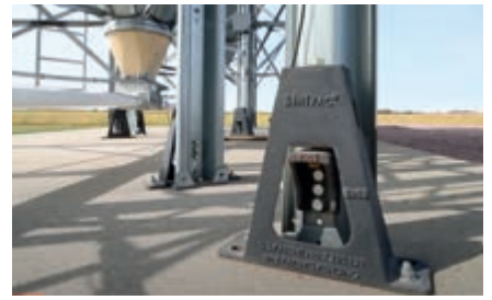
Das QuadScale-Wiegemodul lässt sich ohne ein komplettes Anheben des Silos nachrüsten
