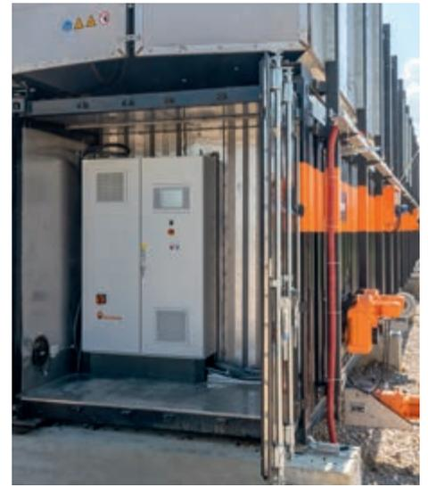
Armario de control para un funcionamiento completamente automático
