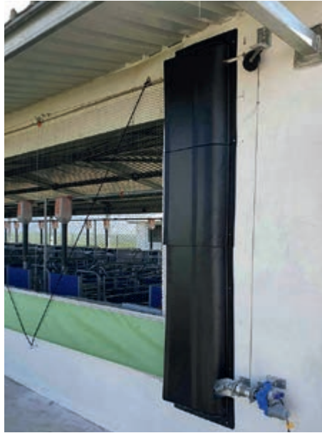
L'entraînement à treuil enroule et déroule le rideau de façon sûre
