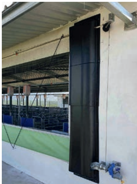
Silnik wyciągarki bezpiecznie zwija i rozwija kurtynę
