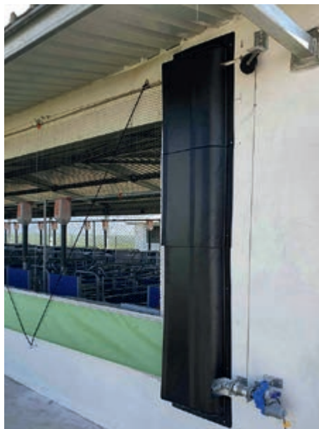
Двигун лебідки надійно намотує і розмотує штору
