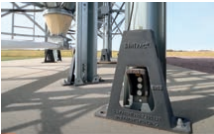
Модуль QuadScale може бути доустановлений без необхідності повністю піднімати бункер
