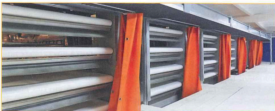
Фото 4. Транспортировочный лифт — автоматическая транспортировка птиц на погрузочную платформу
