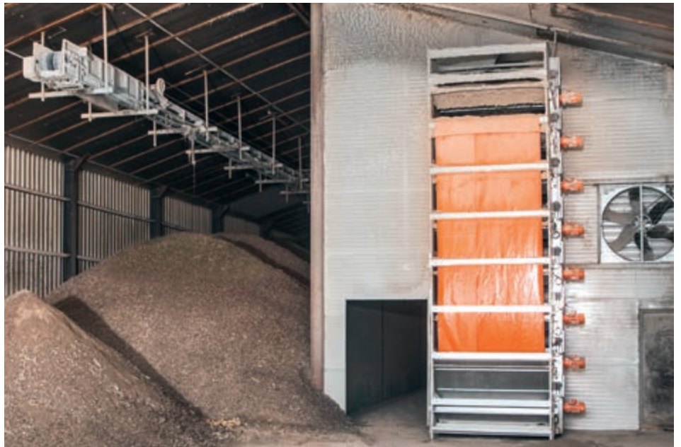
OptiSec mit Kottlager zusammen in einer Halle
