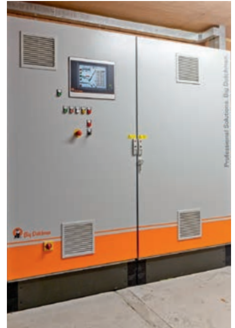
Schaltschrank mit amacs-Funktionsmodul »Kottrocknungstunnel OptiSec«
