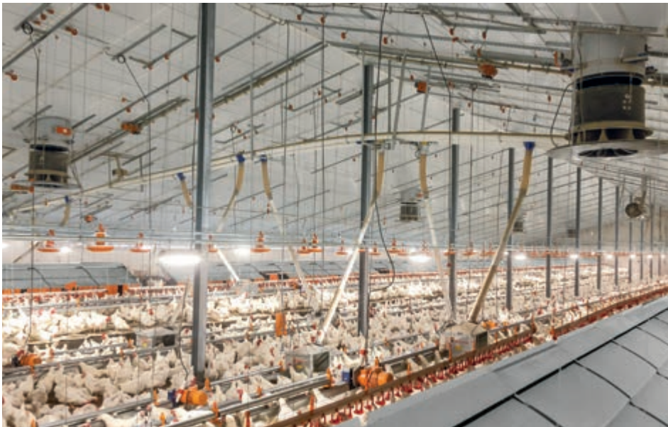
Einsatz des Fumus in einem Broiler-Elterntierstall
