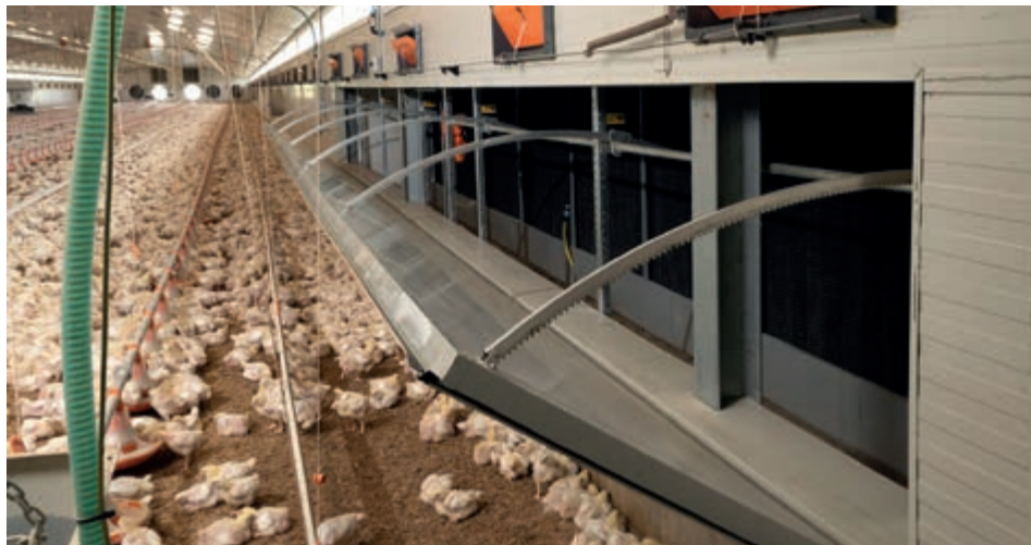
Broilerstall mit Tunnelklappe in den Stall öffnend
