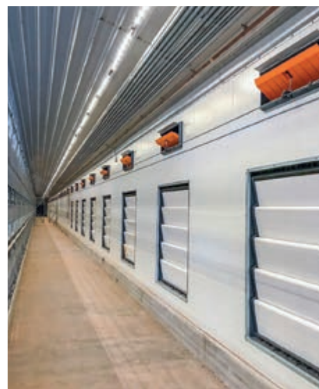
Volierstall mit CombiTunnel-Ventilation bei Einsatz von CL-3-1911/F-Flanschventilen und MVT-Shuttern
