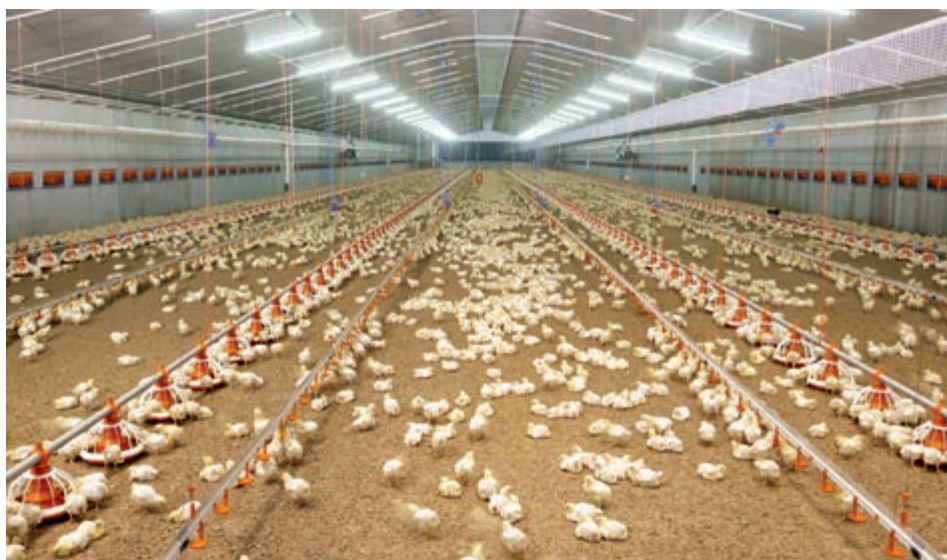
Typischer Broilerstall in Nordeuropa mit Zuluftführung über CL-3-1911/F-Flanschventile
