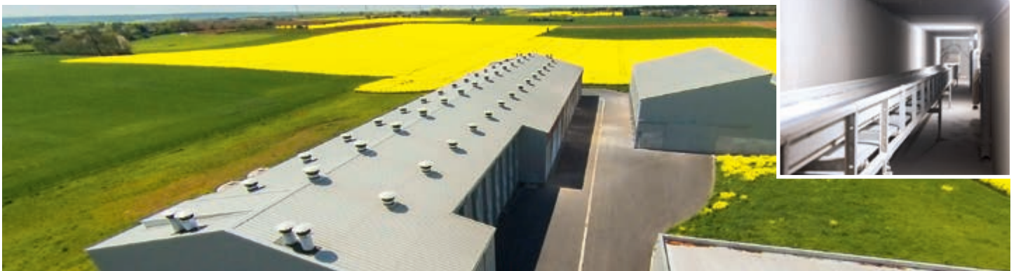
Solución ecológica: dos OptiPlate para 205.000 gallinas ponedoras en el lado longitudinal de la nave; el estiércol secado se transporta bajo tierra al almacén de estiércol
