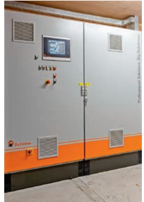
Armario de control con módulo de funciones amacs «túnel de secado de estiércol OptiSec»
