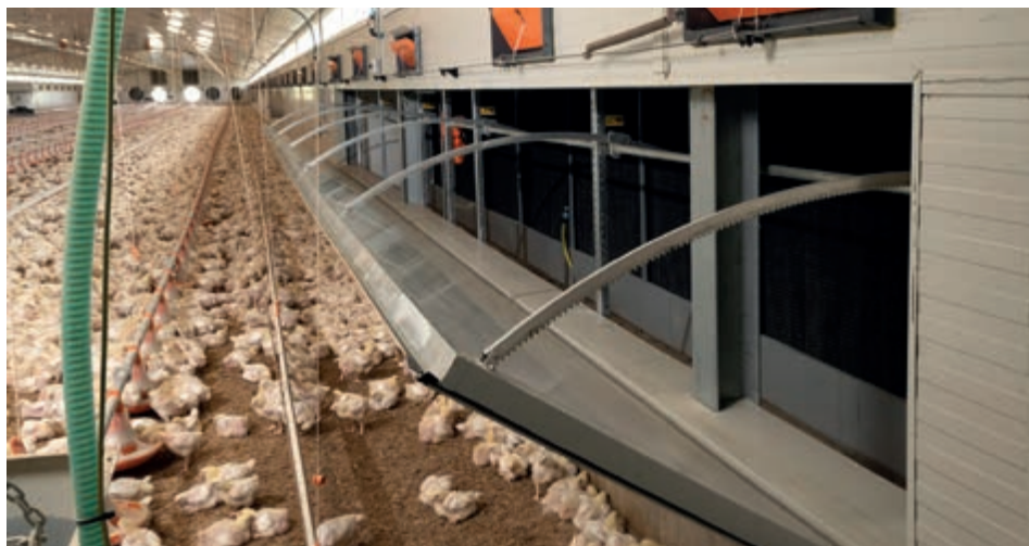
Nave de pollos de engorde con trampilla de túnel que abre hacia el interior de la nave
