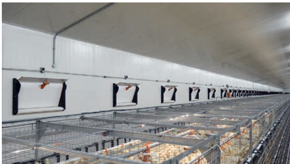
AviMax transit: Conducción de aire a través de la entrada con brida CL Flex
