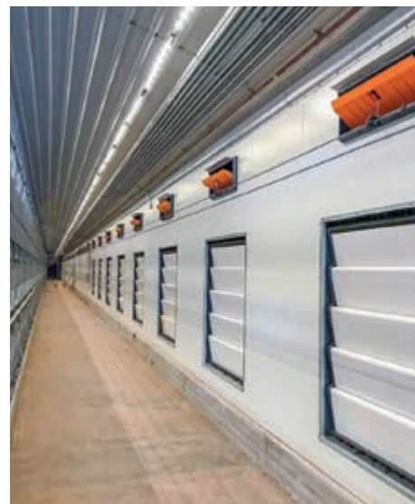
Nave con aviaros, ventilación CombiTunnel y utilización de entradas con brida CL-3-1911/ F y persianas MVT
