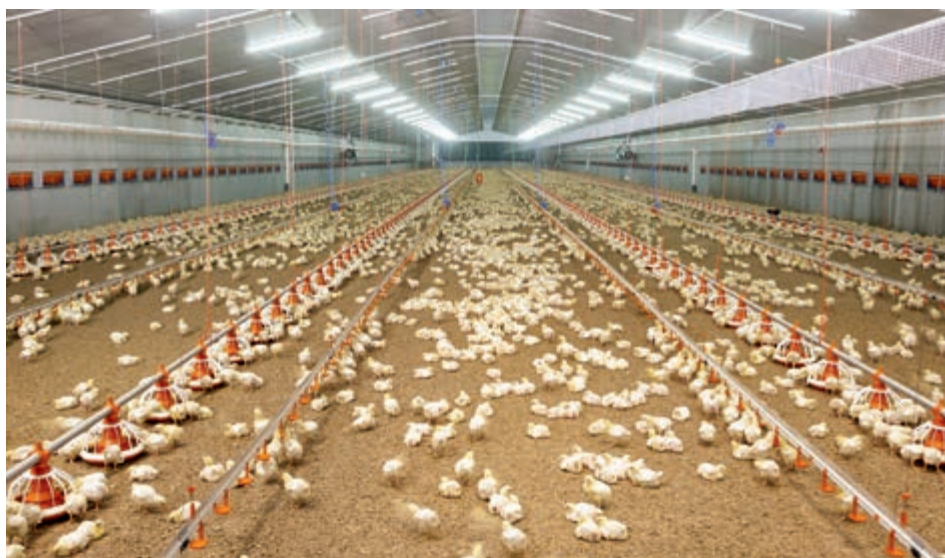
Bâtiment de poulets de chair caractéristique du nord de l'Europe avec une ventilation effectuée par des volets à bride CL-3-1911/F
