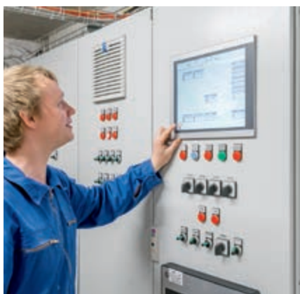
15 calowy wyświetlacz dotykowy w szafie sterowniczej amacs
