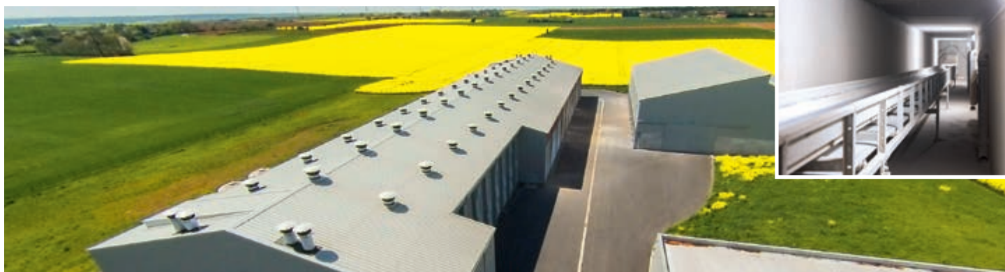
Rozwiązanie przyjazne dla środowiska: 2 OptiPlate dla 205.000 kur niosek na podłużnej ścianie kurnika; podziemne transportowanie wysuszonego pomiotu do magazynu do składowania pomiotu
