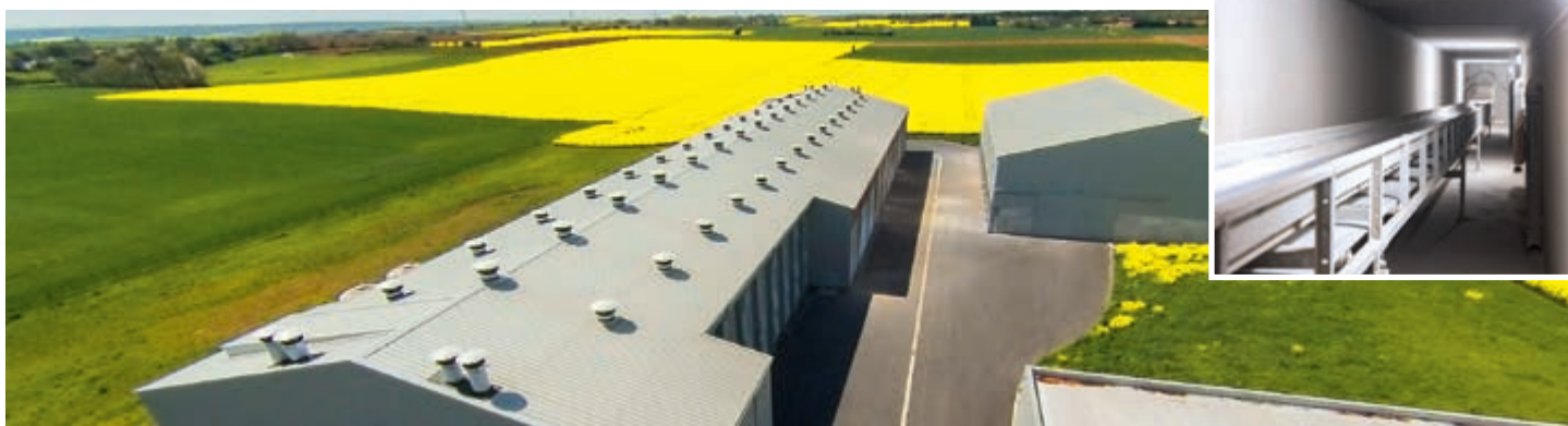
Экологичное решение: 2 установки OptiPlate у продольной стены корпуса на 205 000 несушек; транспортировка высушенного помета в пометохранилище осуществляется под землей
