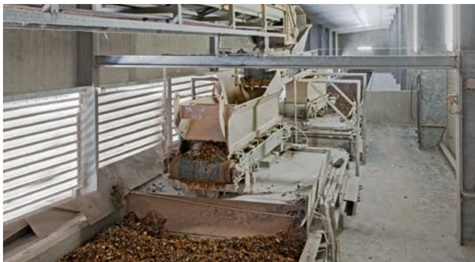
Станция загрузки: здесь размещены сразу 2 установки OptiPlate, загружаемые одним транспортером
