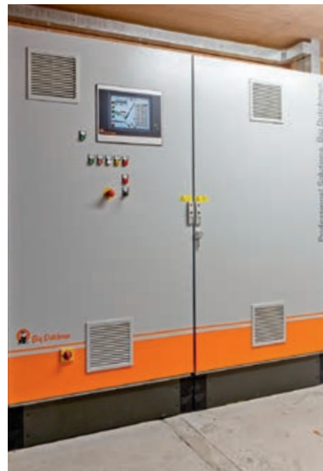
Шкаф управления с функциональным модулем amacs «Установка для сушки помета туннельного типа OptiSec»
