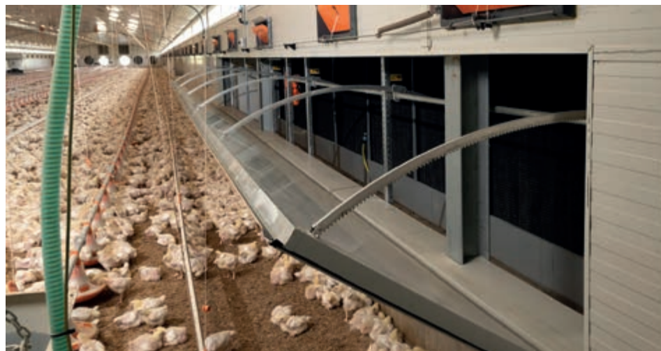
Приміщення для бройлерів з тунельною заслінкою, що відкривається всередину приміщення
