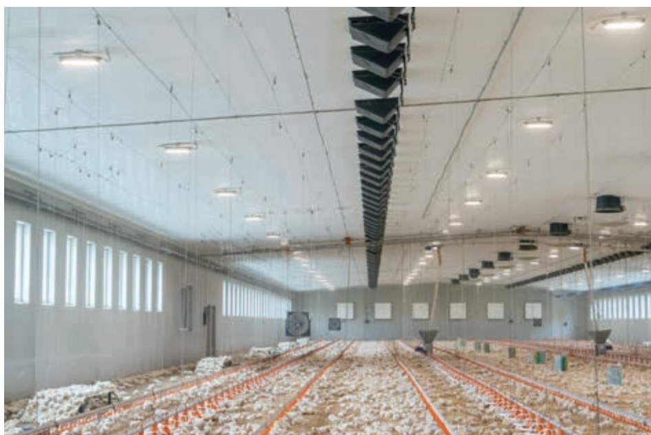
Використання вентиляційного клапана CL 1540 у стелі пташника для бройлерів
