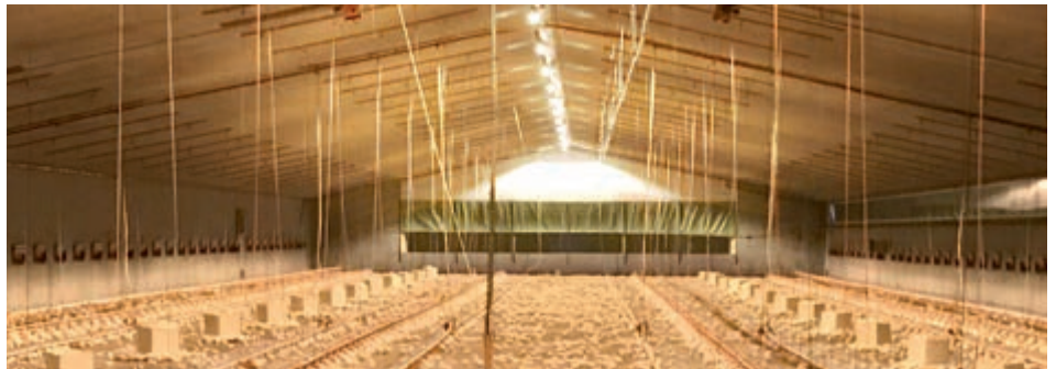
Aurora 540: цілий ряд світильників можна заощадити в низьких приміщеннях завдяки оптиці типу "крило кажана"
