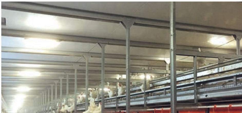
Die weiße und glatte Unterseite der Kunststoff-Platten ermöglicht den ungehinderten Zuluftstrom in Stallquerrichtung
