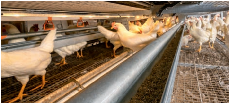
Étage inférieur dans NATURA Step avec l'approvisionnement en aliments et en eau
