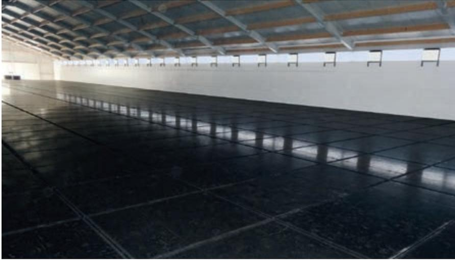
Vue du plafond intermédiaire avant le montage du deuxième niveau. Le plafond intermédiaire se compose de plaques en plastique
