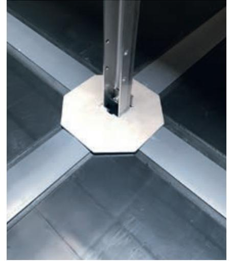
Les montants de l'installation sont fixés au plafond intermédiaire à l'aide d'un pied en inox
