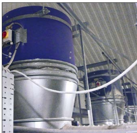
Un ventilateur radial R3G 400 par rangée
