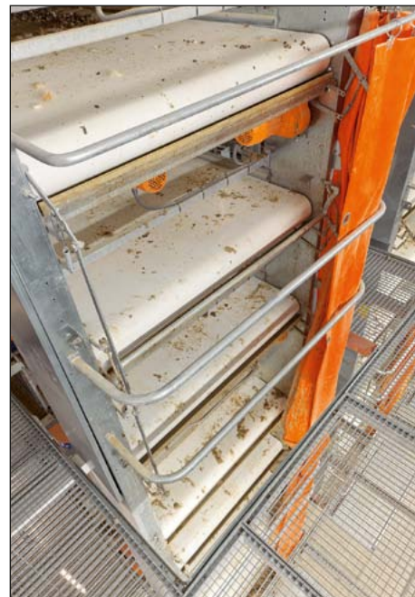
Extrémité du tapis d'évacuation
