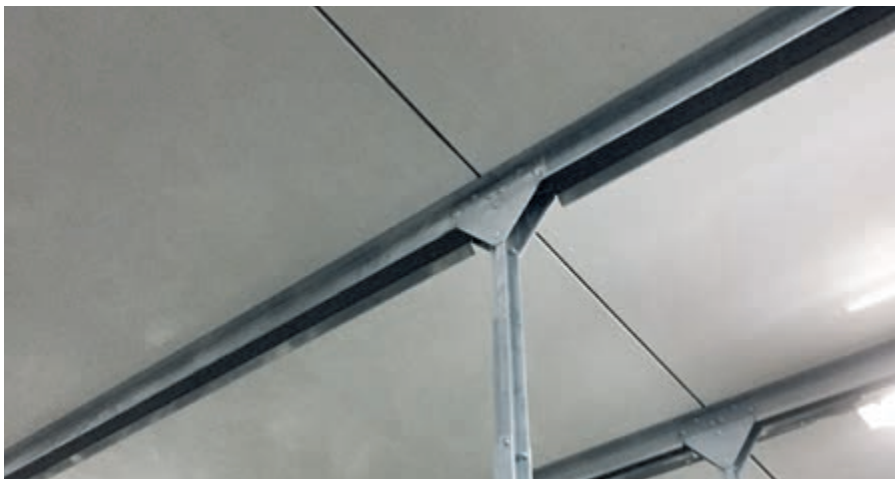
Biała i gładka, dolna powierzchnia płyt z tworzywa sztucznego, umożliwia poprzeczny przepływ powietrza w kurniku bez żadnych zakłóceń a także pomaga w jaśniejszym oświetleniu poziomu dolnego
