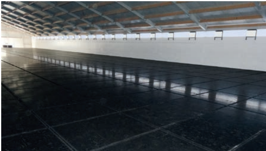
Widok na sufit pośredni wykonany z płyt z tworzywa sztucznego przed montażem woliery na drugim poziomie
