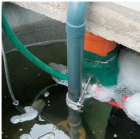
Použití ponorného čerpadla pro zásobování CoolBoxu vodou
