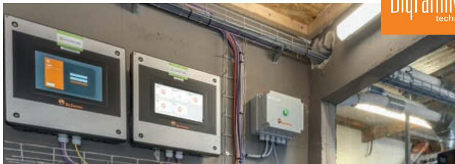
Bis zu 10 TriSort pro werden von einem Controller 510 pro gesteuert, der hier im Büro neben dem Fütterungscomputer für die DryExact pro montiert ist.
