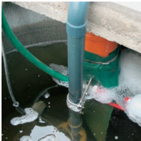
Einsatz einer Tauchpumpe zur Wasserversorgung der CoolBox
