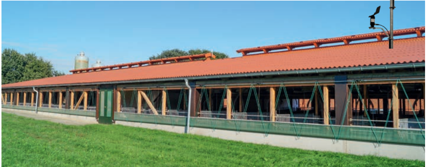
Außenklimastall mit Gardine als Schutz vor Witterungseinflüssen
