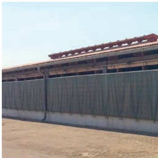
Rollgardine von oben nach unten öffnend mittels Stellmotor EWA
