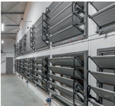
MultiVent 17 M in der Giebelwand für Tunnelventilation
