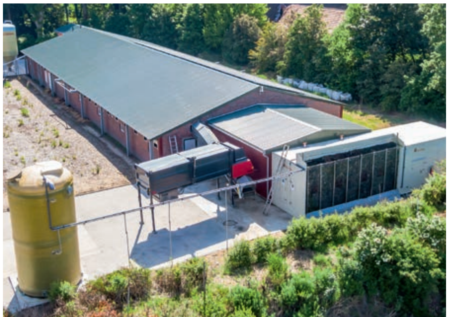
Xaletto®-Stall mit Abluftwäscher PURO-X
