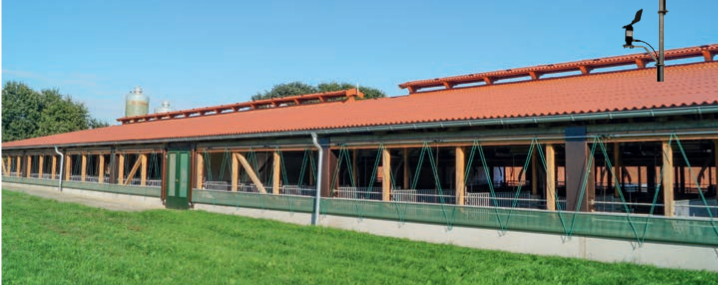
Nave de clima exterior con cortinas como protección frente a las influencias atmosféricas
