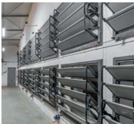
MultiVent 17 M en pared frontal (frontón) para ventilación túnel
