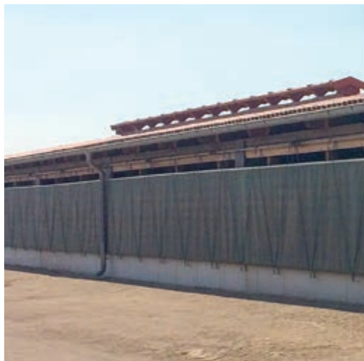
Cortinas enrollables que se abren de arriba a abajo mediante servomotor EWA
