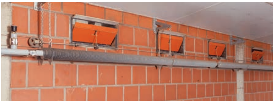
Tubo radiante de aluminio – ideal combinado con entradas de aire en pared CL 1200
