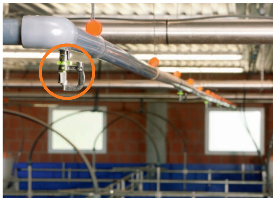
Sistema de remojo fijo en una sala de engorde
