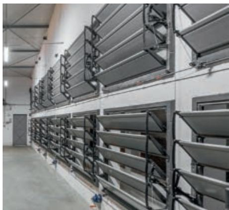
MultiVent 17 M dans le mur pignon pour la ventilation tunnel
