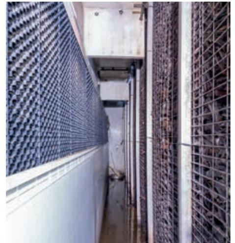
À gauche se trouve le séparateur de gouttes, à droite la paroi à biofiltre garnie de racines d'arbres
