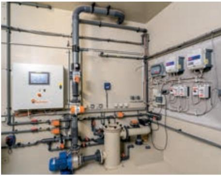
Local technique préassemblé en usine avec commande
