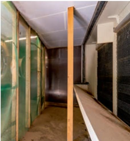
Les ventilateurs poussent l'air vicié par la paroi filtrante ; filet pour une bonne répartition de l'air dans la paroi filtrante
