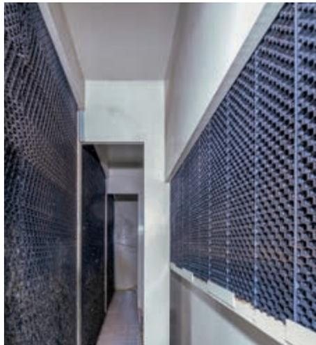
Paroi filtrante à gauche et séparateur de gouttes à droite
