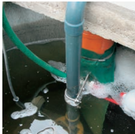
Utilisation d'une pompe immergée qui approvisionne la CoolBox en eau
