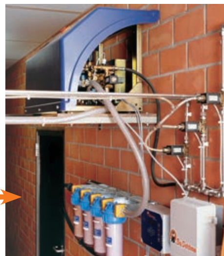
Pompe centrale avec unité à 4 filtres
