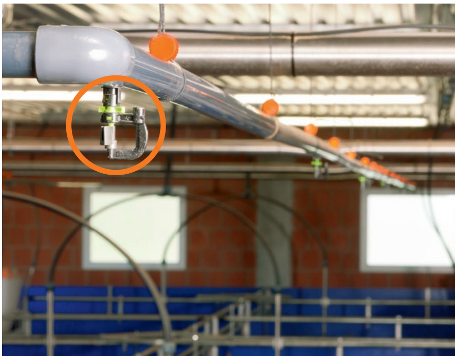
Stacjonarny system spryskiwania w kojcu dla tuczników do profesjonalnego czyszczenia chlewni
