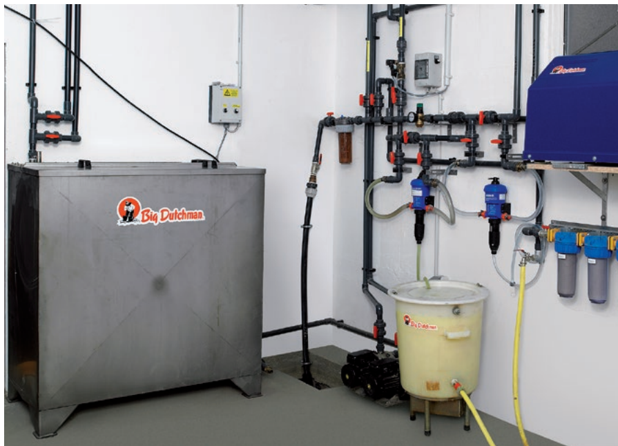
Pomieszczenie z małym (60 l) i dużym (1000 l) mieszalnikiem lekarstw i witamin ze stali szlachetnej
