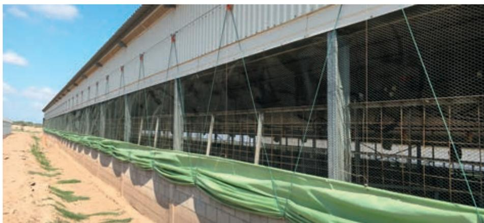
Подъемные шторы представляют собой простой, но эффективный способ управления естественным обменом воздуха в корпусе. Автоматическое открытие и закрытие штор выполняется серводвигателем серии EWA.
