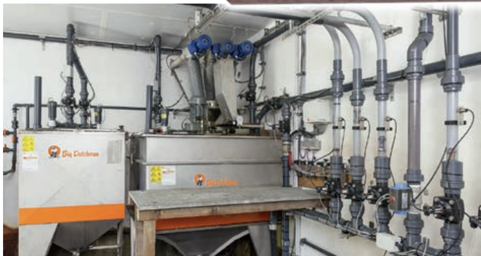
Система с 1 баком, БТВ и 4 тупиковыми линиями ЖЕТ
