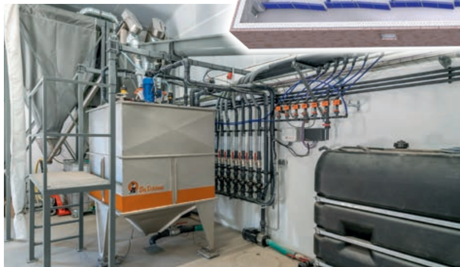
Кормокухня в корпусе для ремсвинок на 1400 мест
