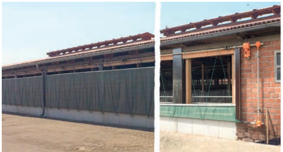
Електроприводні штори з механізмом відкриття зверху вниз за допомогою серводвигуна EWA
