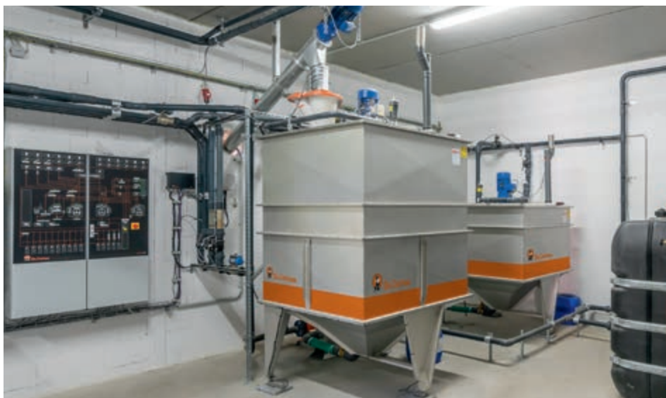
1-бакова система зі зваженим баком для промивання
