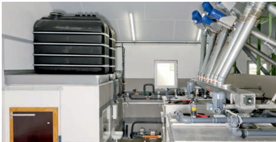
Кормова кухня з 2-ємнісною безвідходною системою годівлі та двома ємностями для свіжої води об'ємом 2000 л
