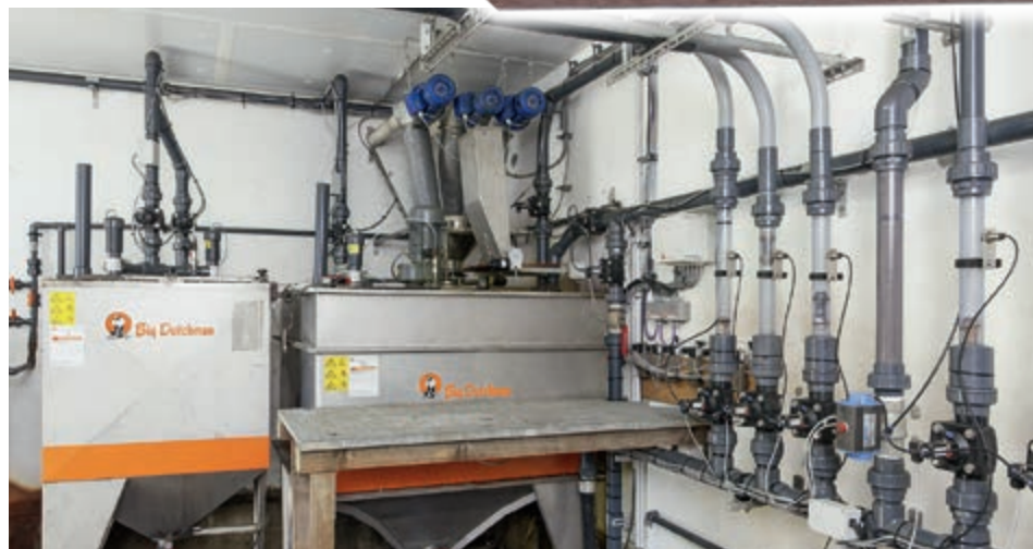
1-бакова система з баком для промивної води та чотирма відгалуженнями JET
