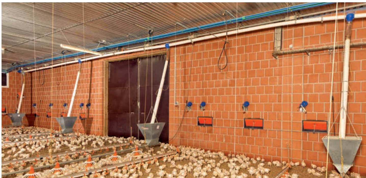
Тросові лебідки для оптимального регулювання висоти поїлок відповідно до віку птиці
